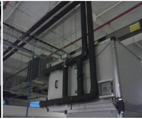
Instalação de pontos de Hidraulica e Refrigeração no Processo
