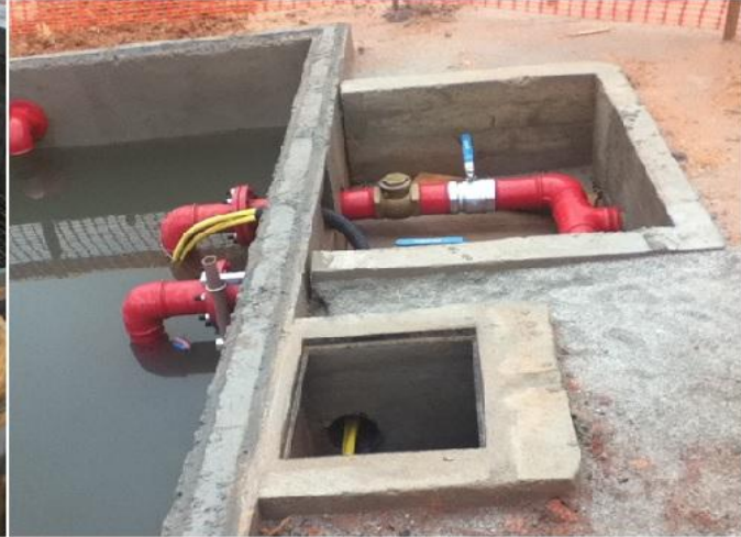
Estação Elevatória de Efluentes Pronta e em funcionamento com Automatismo via Radio Frequência com vazão 5m³/h - Ferragem e Base
