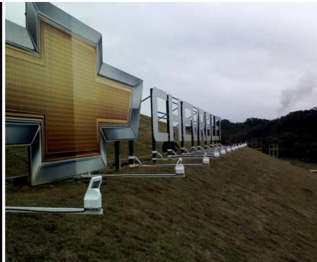
Instalação de Refletores de LED 58w a Prova de Tempo, com Calibração da Direção
