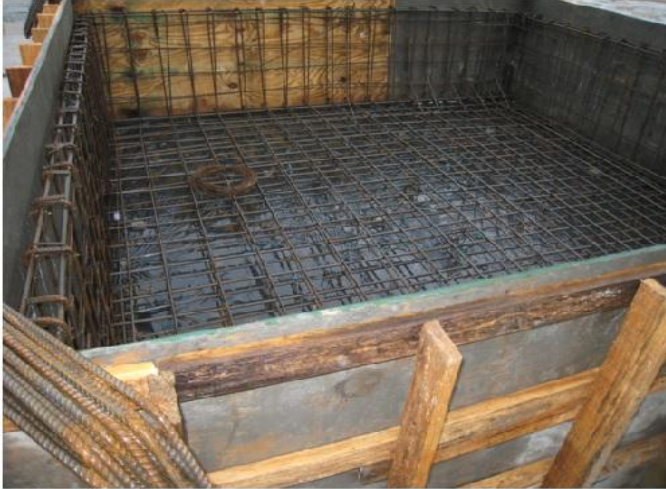
Estação Elevatória de Efluentes Construção de Base de Concreto de 3,5mts x 3,5mts x 3mts
