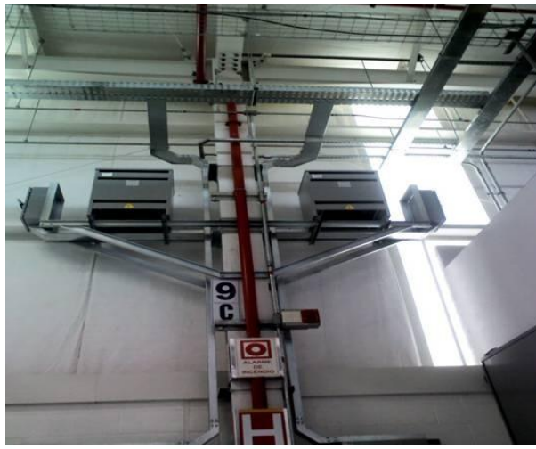
Ampliação dos pontos Elétricos com Instalação de Trafos e Tomadas Elétricas na área Industrial
