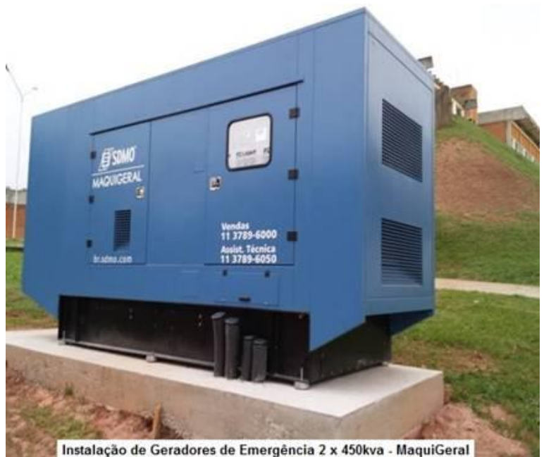
Instalação de Geradores de Emergência 2 x 450kva - MaquiGeral
