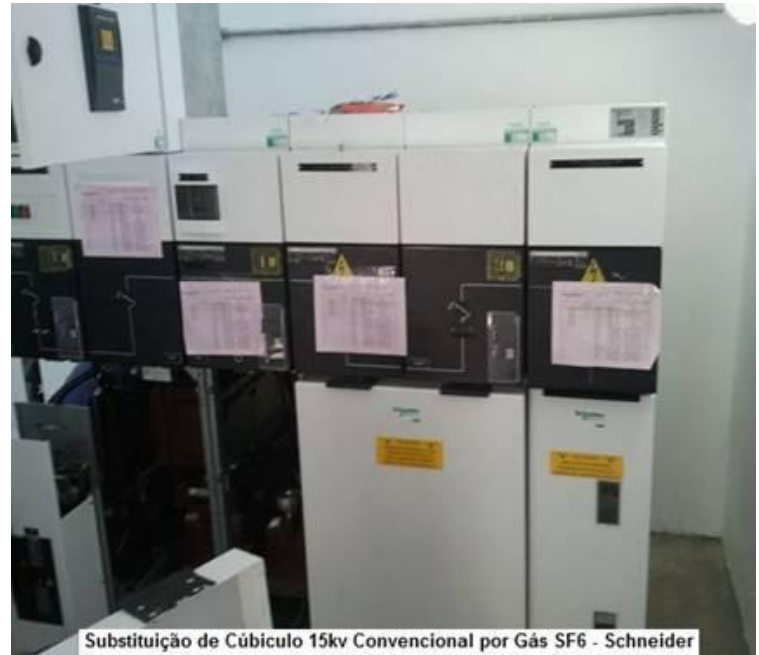
Substituição de Cúbitulo 15kv Convencional por Gás SF6 - Schneider
