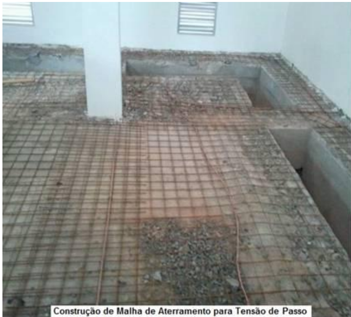
Construção de Malha de Aterramento para Tensão de Passo
