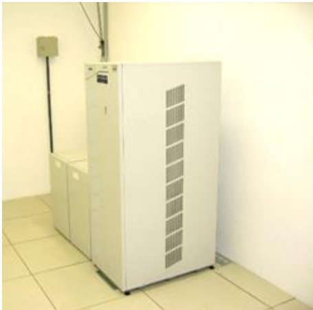
Fachada Scania Sala de datacenter com sistema de ar redundante
